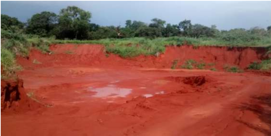
Figura 3 – Vala aberta para receber os resíduos do município de Bom Jardim de Goiás
